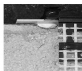
Sto-Fugenflankeprofil-Verbinder dicht am Fugenflankeprofil
