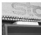
Abstandhalter zur Sicherstellung des Fugenabstands
