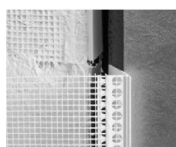
Anschluss des zweiten Profils
