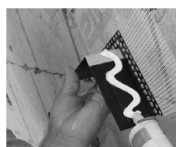
StoColl Fix auftragen
