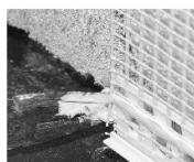
Justieren des Fugenflankeprofil-Verbinders
