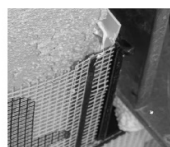
Eingebautes Eckstück mit Fugenflankeprofil-Verbinder
