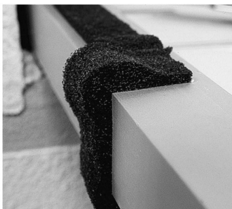
Fig. 2: Trykk sammen fugebåndet ved kanten
