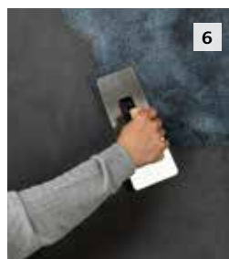
6 Bland StoLook Argento-effektpulveret med StoLook-voksen (tilsett 3 % StoLook Argento). Påfør blandingen med StoCalce Marmorino Finishing Trowel (stålbrett).
