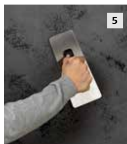
5 Etter litt ekstra tørketid, stålglatt materialet svært med StoCalce Marmorino Finishing Trowel (stålbrett).
