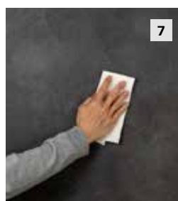
7 Etter at StoLook Wax har tørket, poler du overflaten med en lofri klut.
