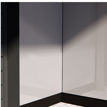
Horisontalt snitt – innvendig hjørne uten trapping
