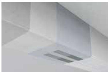
Forsterkning av bjelke med laminat (StoFRP Plate).
